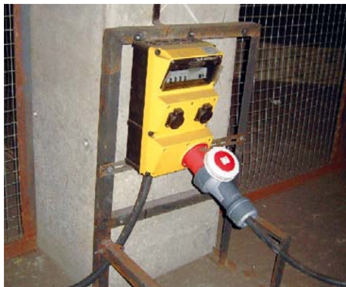
Казанский метрополитен, перегонный тоннель / Россия
